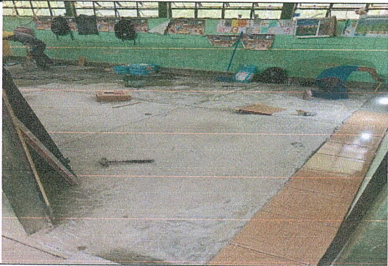
Foto 3. COLOCACIÓN DE ZISA Y SÓCALO.
