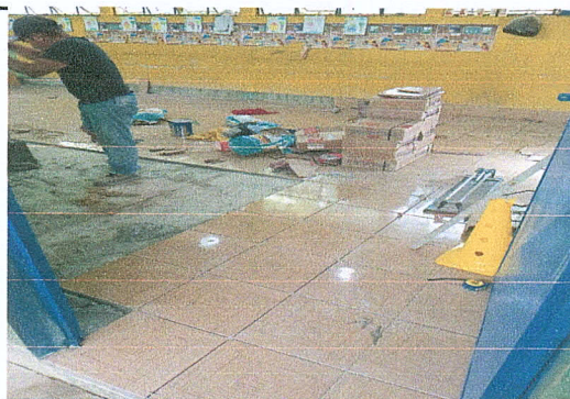
Foto 6: NIVELANDO AREA PARA LA COLOCACIÓN DEL PISO.
